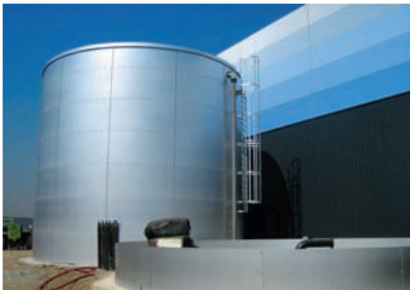
Entrepôt de Chaponnay : alimentation électrique des bureaux par des panneaux photovoltaïques installés sur des cuves sprinkler.
